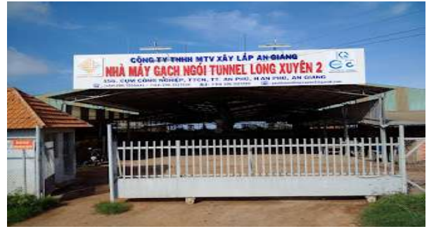
Nhà máy gạch ngói tunnel Long Xuyên 2
