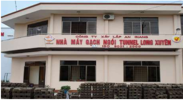
Nhà máy gạch ngói tunnel Long Xuyên
