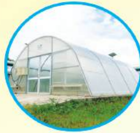
Thiết kế, lắp đặt Nhà sấy năng lượng mặt trời
